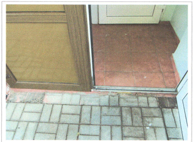
Фото 10 Дверь внешняя входная (запасной выход)
