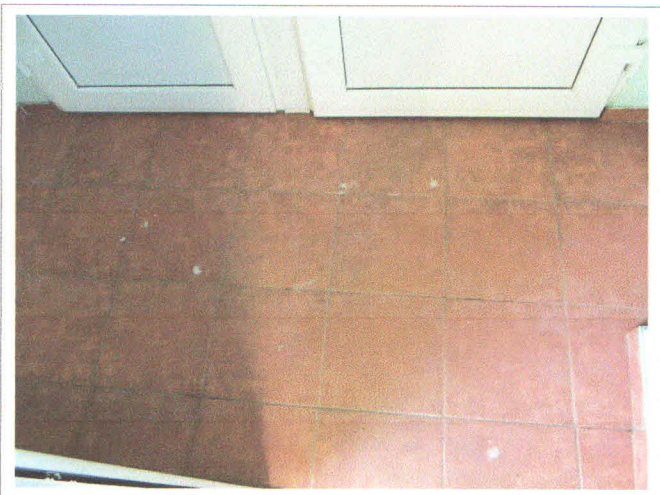
Фото 11 Тамбур (запасной выход)
