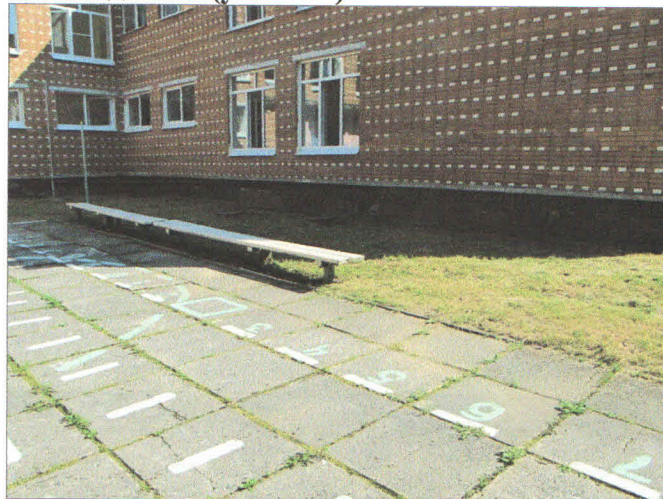
Фото 2 Путь (пути) движения на прилегающей территории
