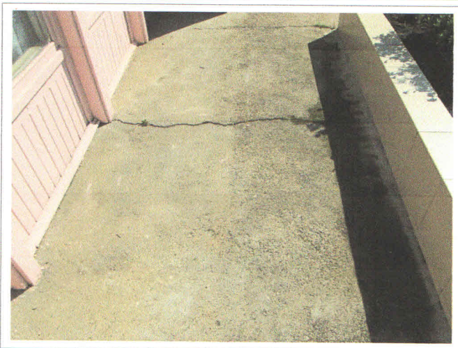
Фото 5 Входная площадка перед входной дверью
