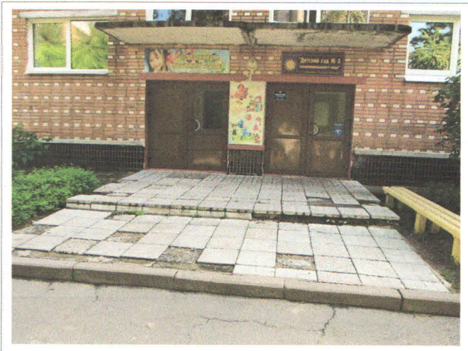
Фото 9 Входная площадка (запасной выход)
