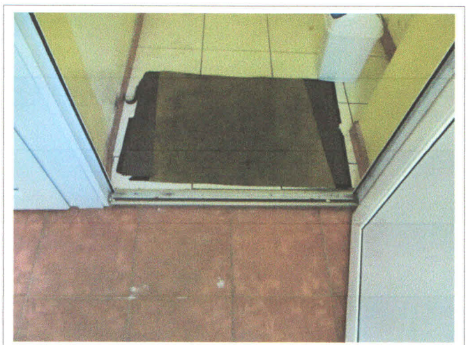
Фото 12 Дверь внутренняя входная (запасной выход)
