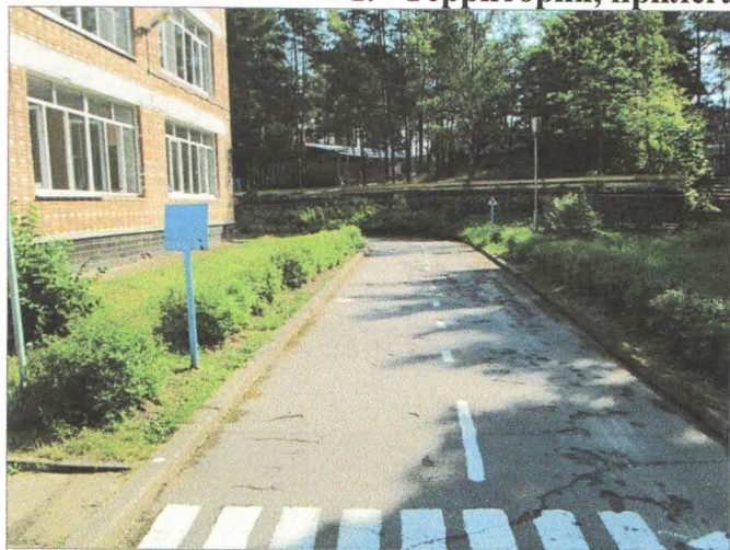
Фото 1 Путь (пути) движения на прилегающей территории
